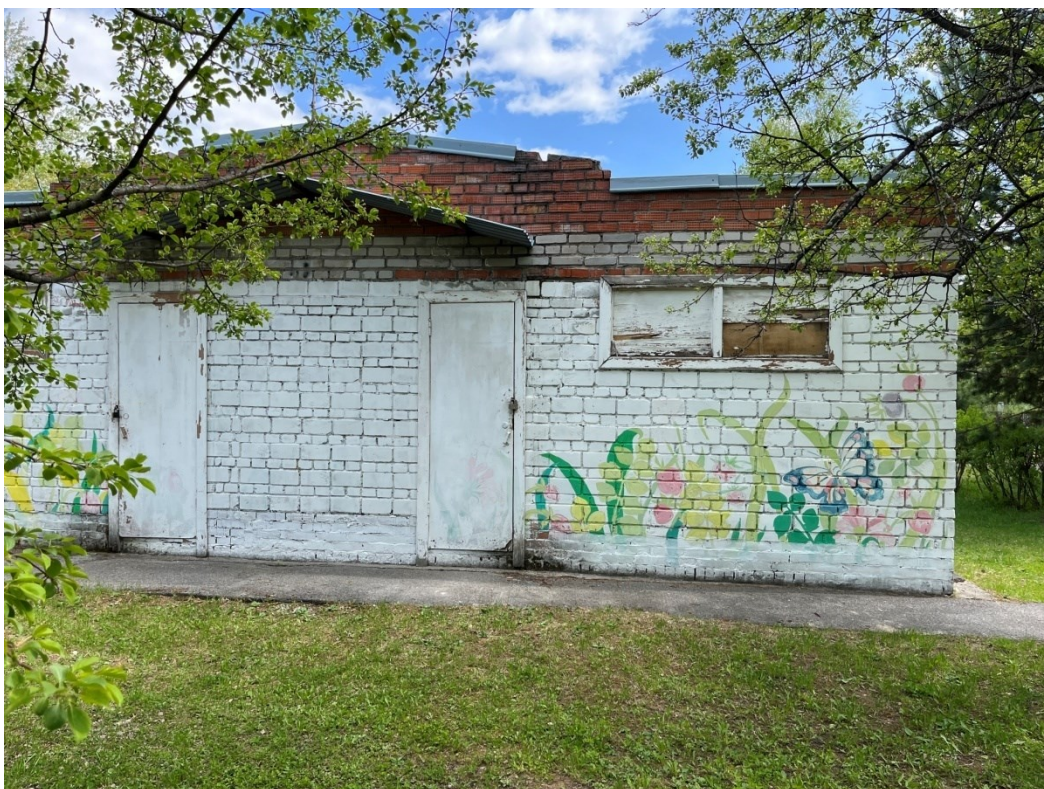
4. Фасад хозяйственной постройки на территории Художественной школы, ул.Куйбышева, 12
